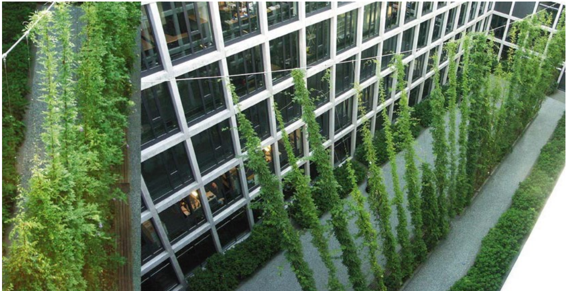
38. attēls. Ažūras vītenaugu konstrukcijas. Attēla avots: www.green-walls.co.uk.
