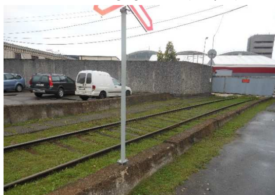
33.attēls. Izbūvētās dzelzceļa slīdes uz zemesgabalu Daugavgrīvas ielā 93
