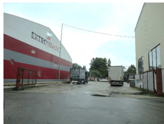
4.-7.attēls. Lokālpārplānojuma teritorija (zemesgabals Daugavgrīvas ielā 93)
