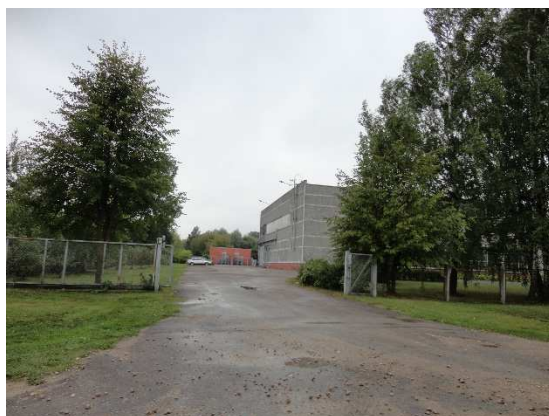
19.attēls. Tehniskā apbūve Daugavgrīvas ielā 101 – kanalizācijas sūkņu stacija
