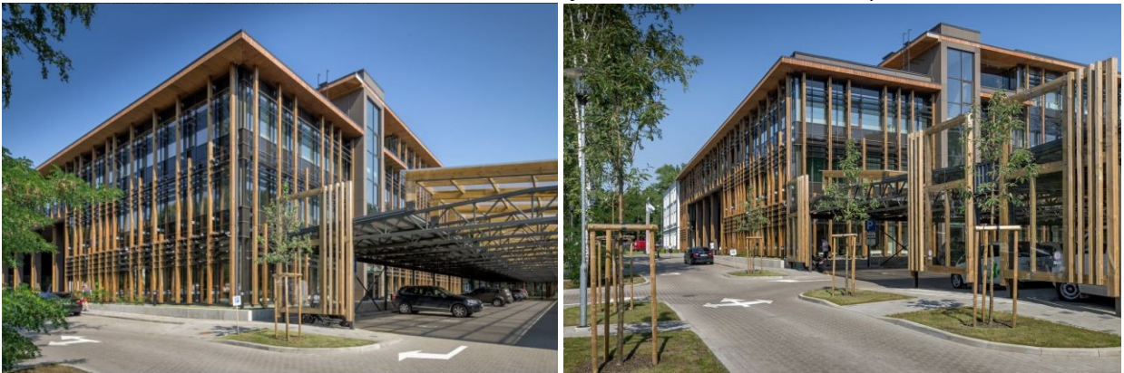
33. attēls. Atdaloša konstrukcija - Latvijas valsts meži administrācijas ēka un autostāvvietā Vaiņodes ielā 1, Rīgā. Attēla avots: lvm.lv.
