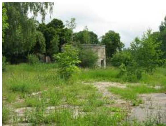
48.attēls. Pārbūvējamā saimnieciskās kanalizācijas sūkņu stacija (2014.gads)
