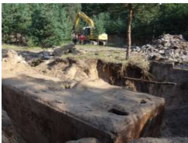
61.attēls. Esošo pazemes būvju un iekārtu demontāžas darbi Avots: SIA „Sužu pussala”, 2014
