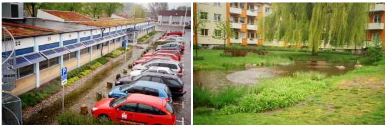
79. un 80.attēls. Grāvis kalpo kā savdabīga barjera starp mašīnu novietnes joslu un ēkas sienu. Sekls dīķis piecstāvu māju pagalmā
