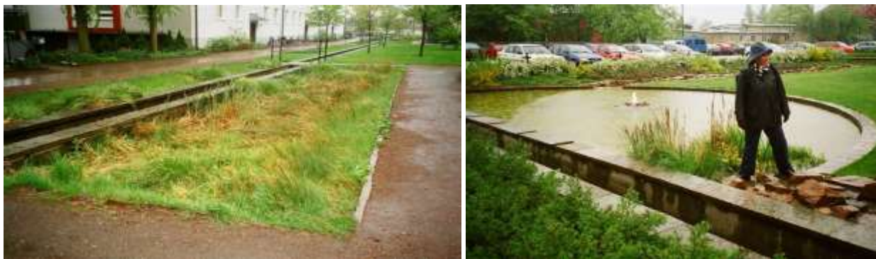
77. un 78.attēls. Mākslīgā mitraīne vienotā sistēmā ar lietusūdeņu kanālu un lietusūdeņu baseinu ar strūklaku. Ūdens augiem baseinā ir pietiekoši daudzumā. Baseina ūdeni var izmantot arī līdzās esošo augu mitrināšanai
