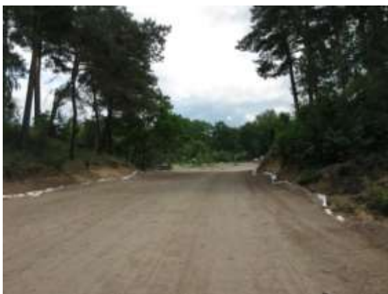
42.-43.attēls. Būvniecības stadijā esošais ceļš, plānotā iela
