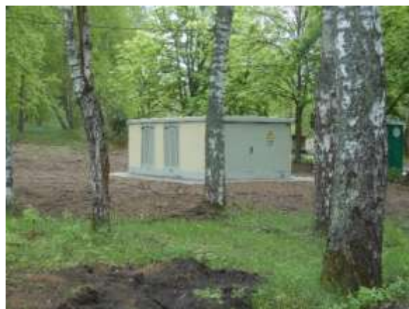
46.attēls. Esošā transformatoru apakšstacija (2015.gads)
