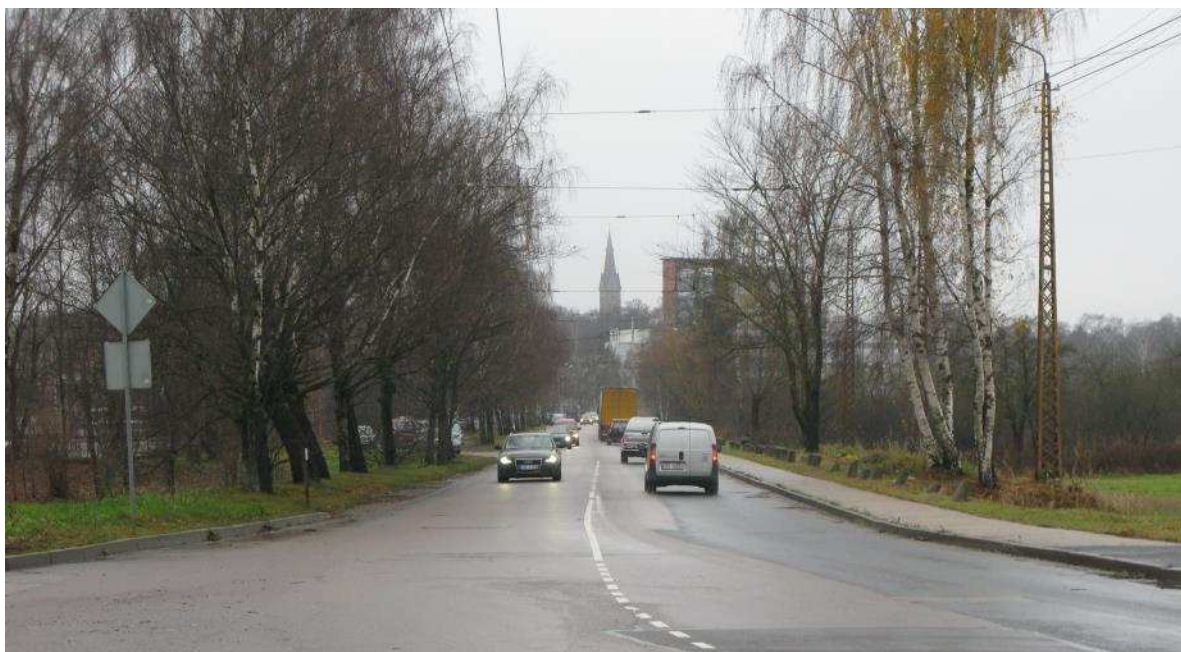
39.attēls. Skats uz Vienības gatvi no Jelgavas ielas krustojuma. Foto, 2015.
