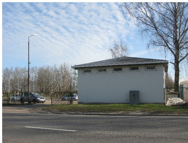
5.attēls. Zemes gabalā esošā ēka un iebrauktuve teritorijā Foto: SIA „METRUM”, 2015.
