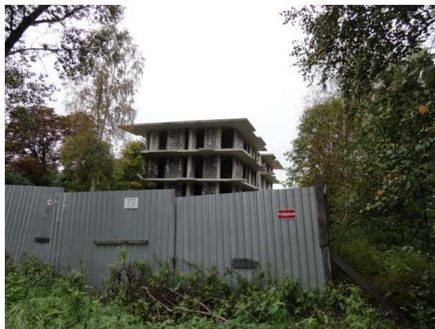
6.attēls. Skats uz lokālplānojuma teritoriju no Jūrmalas gatves
