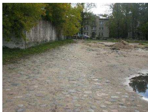
37.attēls. Kaķasēkļa dambis - vēsturiskais bruģis pie krustojuma ar Lugažu ielu un dzelzceļa gājēju pārejas. Avots: SIA "Metrum" 2017
