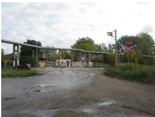
44.attēls. Dzelzceļa pārbrauktuve Kaķasēkļa dambja un Ilzenes ielas krustojumā. Avots: SIA “Metrum” 2017
