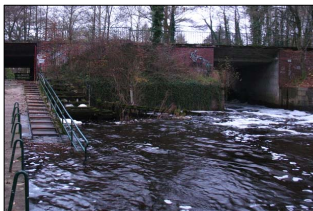
Attēls nr. 3.18. Laivu pārceltuve.
