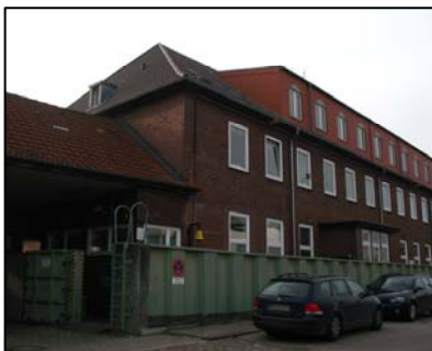
Attēls nr. 3.12. Hidroizolējoša sēta.
