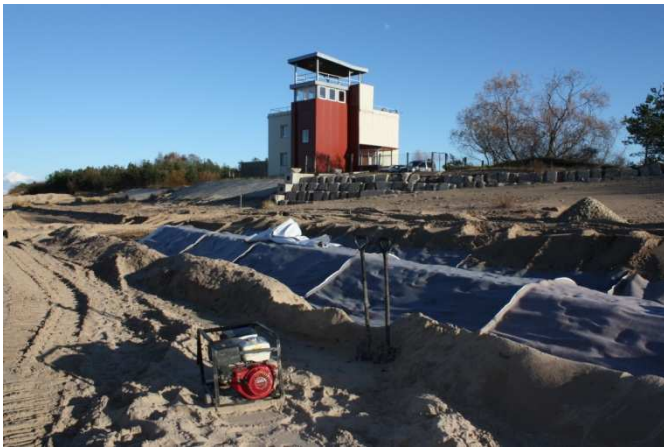
Attēls nr. 5.3. Jūras krasta stiprinājuma izveide pie Austrumu mola. 2011. g.
