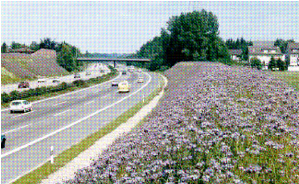
23. attēls. Zemes uzbērums aizsardzībai pret troksni
