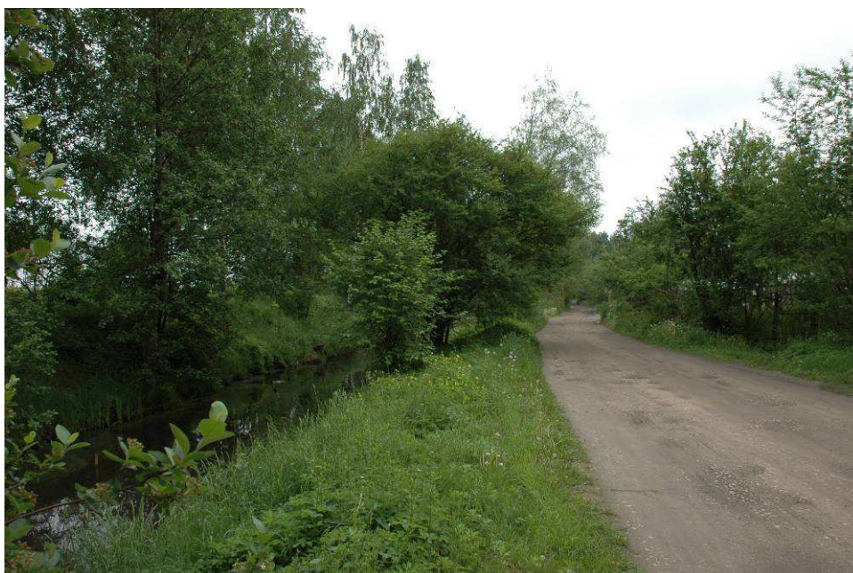
Att. 9 Drenāža starp dārziņiem un TEC-1 dzelzceļu
