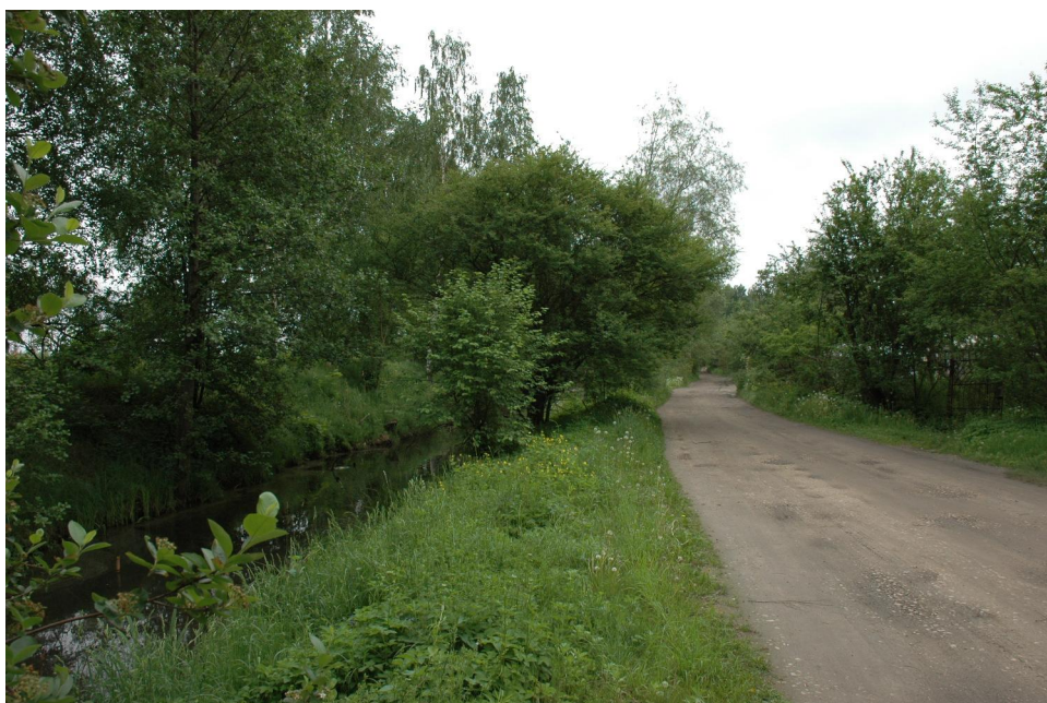
Att. 9 Drenāža starp dārziem un TEC-1 dzelzceļu
