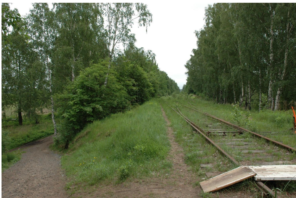
Att. 11 TEC-1 viena no dzelzceļa līnijām
