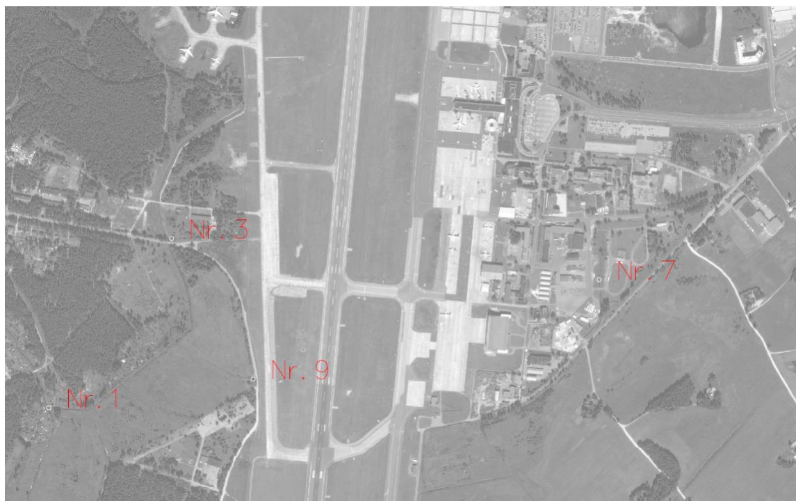
2.9.attēls. Notekūdeņu un lietusūdeņu izplūdes vietas
