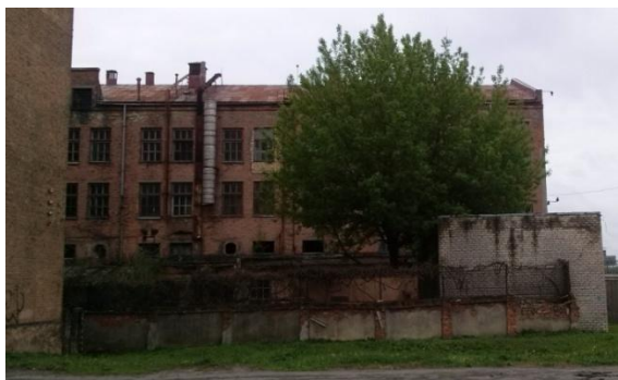
19.attēls. Galvenā ražotnes ēka (005). Skats no Maskavas ielas
