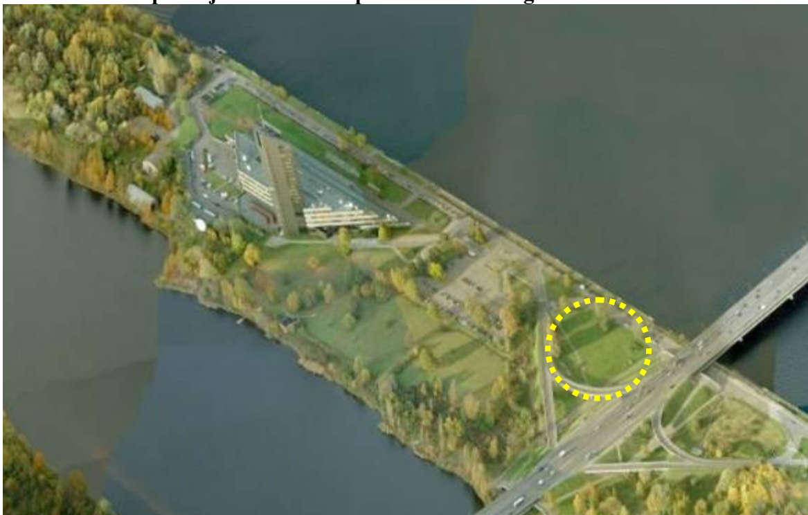
20.attēls. Autostāvvietas ar apstādījumiem Salu tilta nobrauktuvju mezgla zonā.
