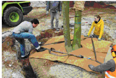
Risinājums stāda sakņu kamola nostiprināšanai
