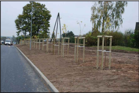
Koka stumbra nostiprināšana ar trim apaļkoka mietiem
