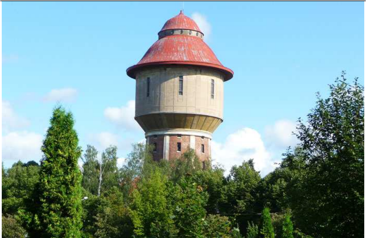
19.attēls. Čiekurkalna ūdenstornis
