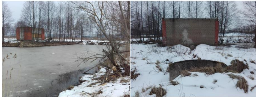
Krājbaseins un sūkņu stacijas ēka Priedaines ielā 41A
