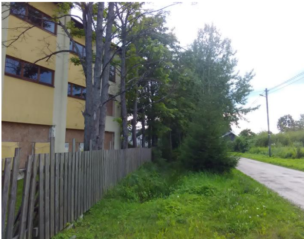
17. Attēls. Apbūve lokālplānojuma teritorijā zemesgabalā Ķiburgas ielā 10E.
