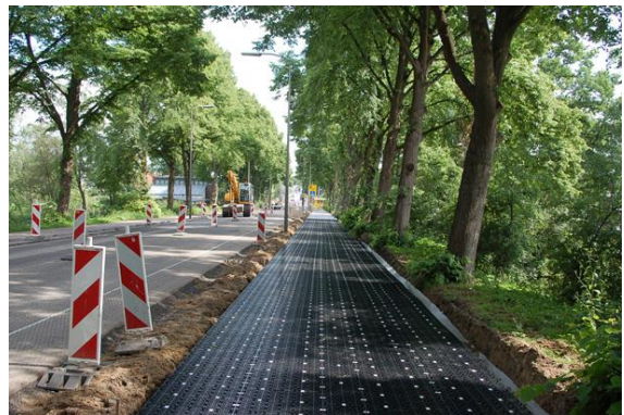
41. attēls. Slodzi izlīdzinošās sistēmas piemērs. Permavoid 150mm. Avots: permavoid.co.uk.
