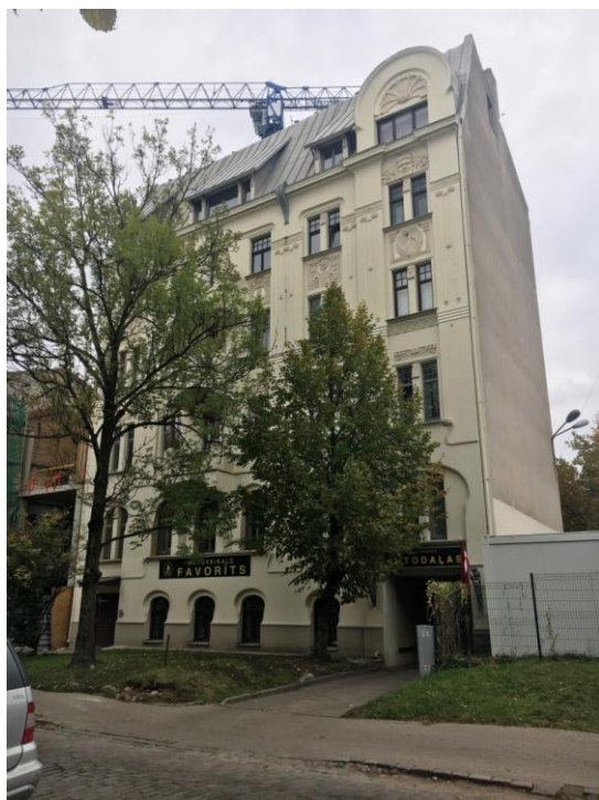
8.attēls. Ēka Strēlnieku ielā 6.
