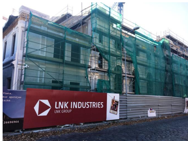
31.attēls. Būvniecības darbi zemesgabalā Strēlnieku ielā 8.
