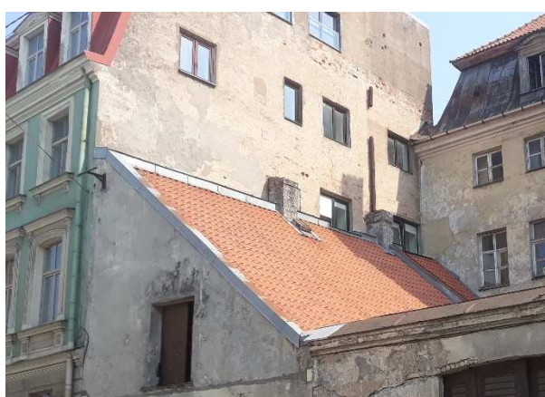
47.attēls. Ēku Anglikāņu ielā 5 un Pils ielā 7 savienojums Foto: SIA "METRUM" 2019.gads
