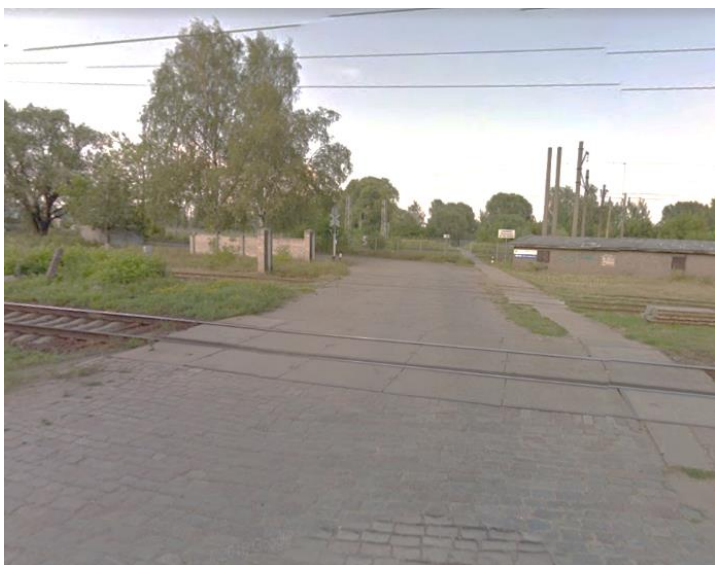
1520mm dzelzceļa pārbrauktuve uzņēmumu transportam un ietve, kas turpinās kā dzelzceļa gājēju pāreja
