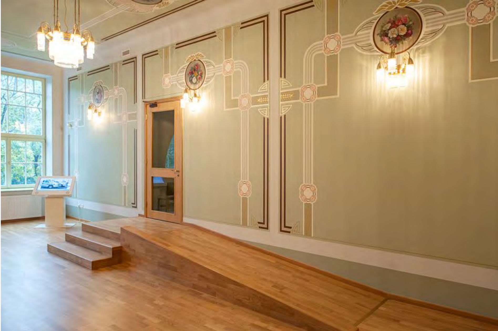
Kultūras pils „Ziemeļblāzma”: Neatbilstošs pandusa risinājums un izmantotais materiāls.
