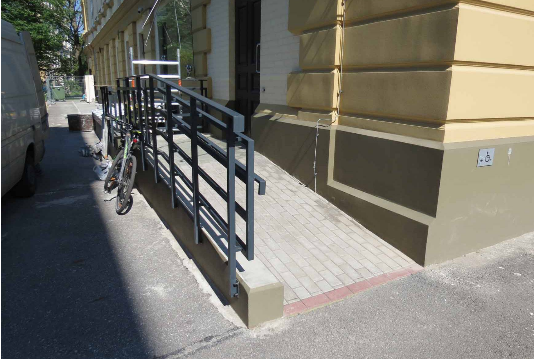
Klīnika Vingrotāju ielā 1: Nepieļaujams pandusa risinājums un neatbilstošas proporcijas
