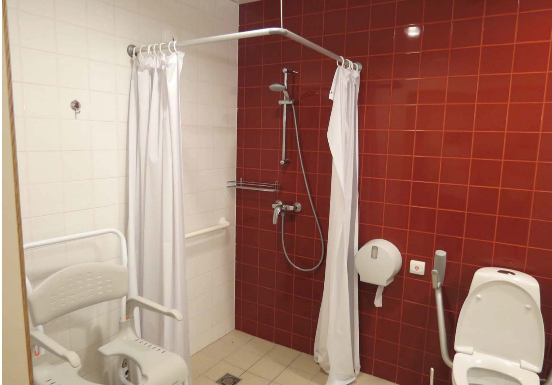
Rīgas 1. slimnīcas 8. korpusa pārbūve: Veiksmīgs WC un dušas risinājums. Ir fons, uz kā izcelties aprīkojumam. Poda izvietojums nav optimāls.
