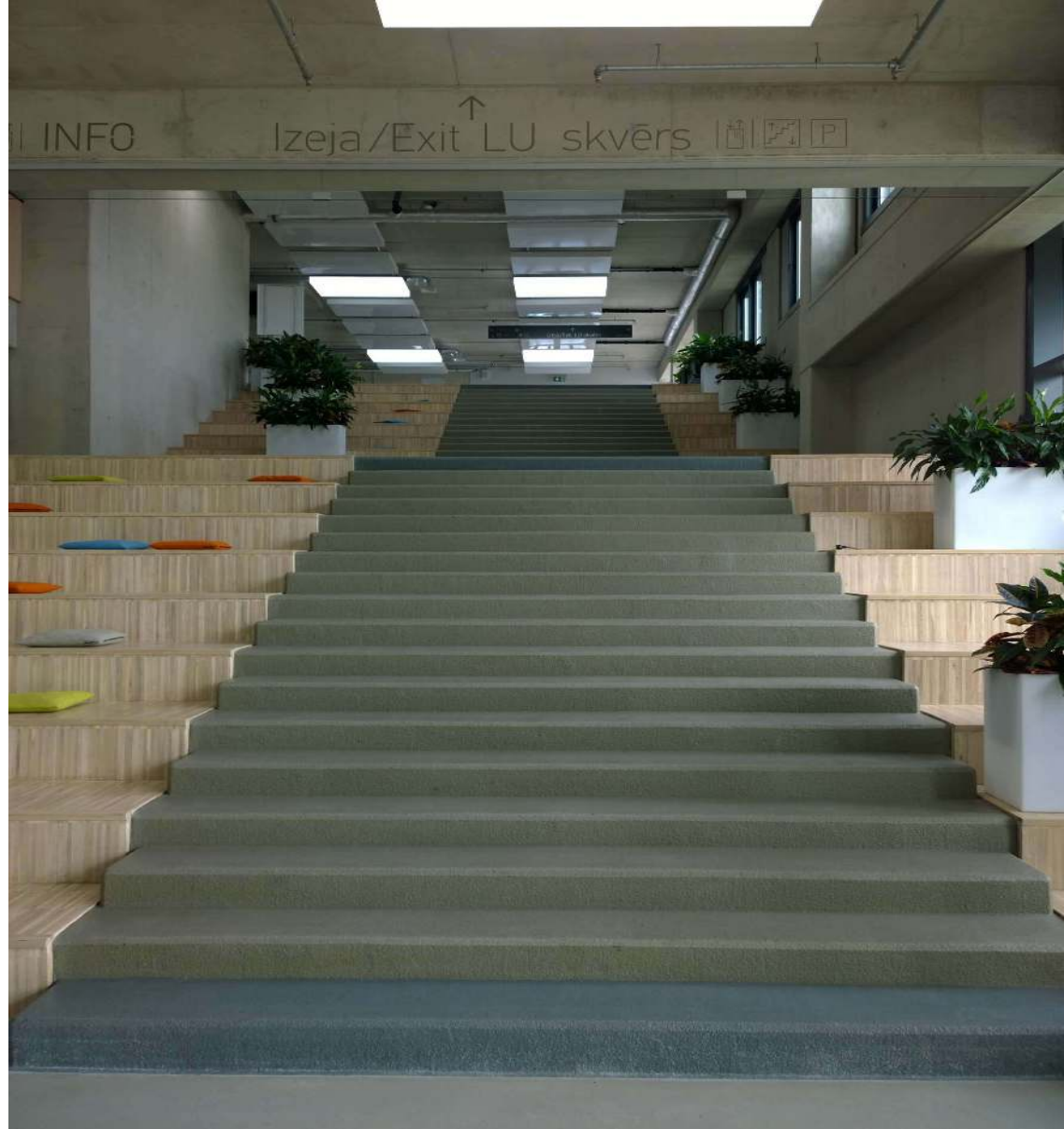
LU Dabaszinātņu akadēmiskā centra jaunbūve Jelgavas ielā 1; Trūkst margu pie augstām kāpnēm.
