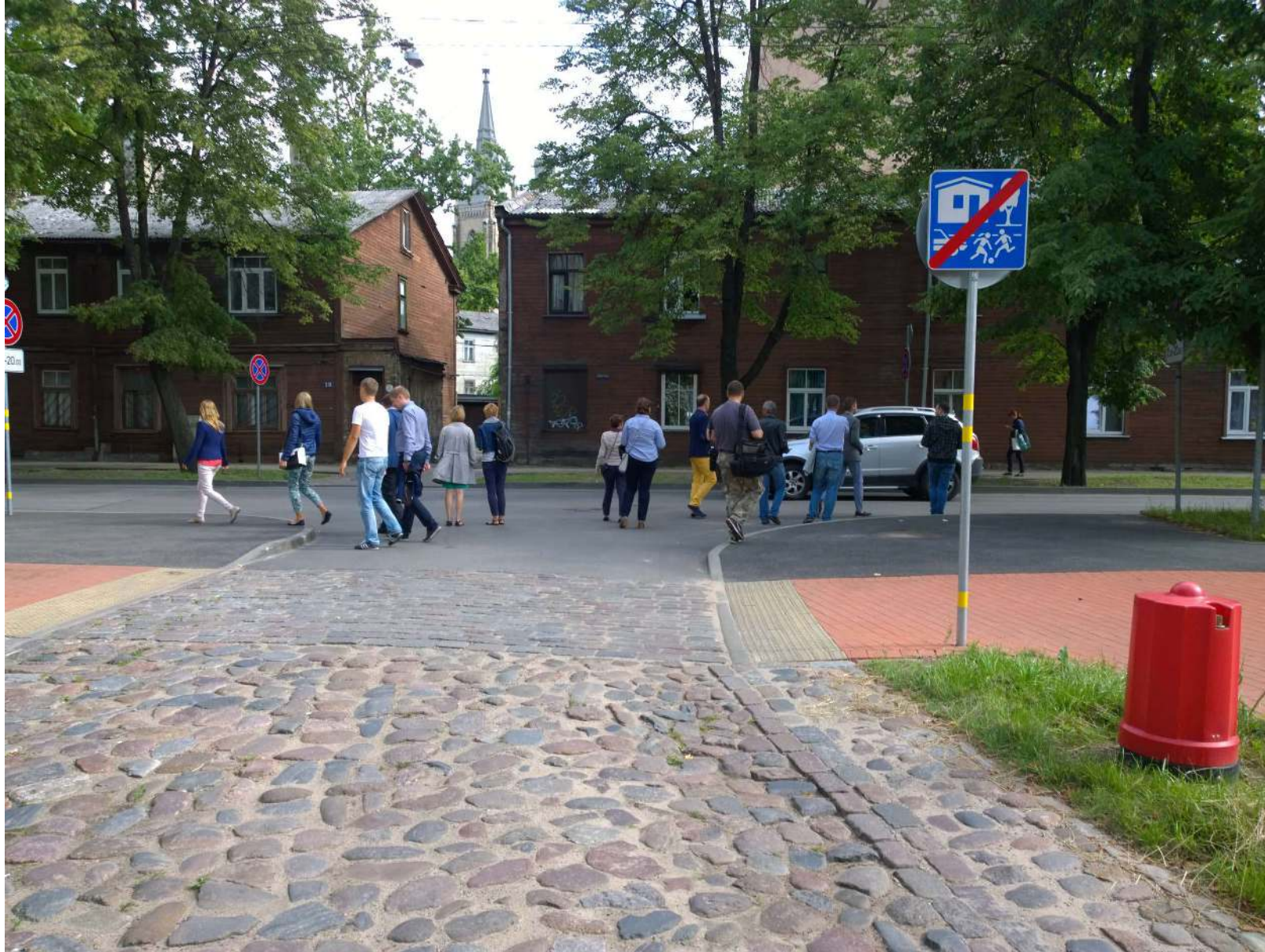
Sparģeļu, Lienes, Pļavas un Zaķu ielas pārbūve Krāsotāju 9: Nevaiksmīgs gājēju pārejas risinājums.
