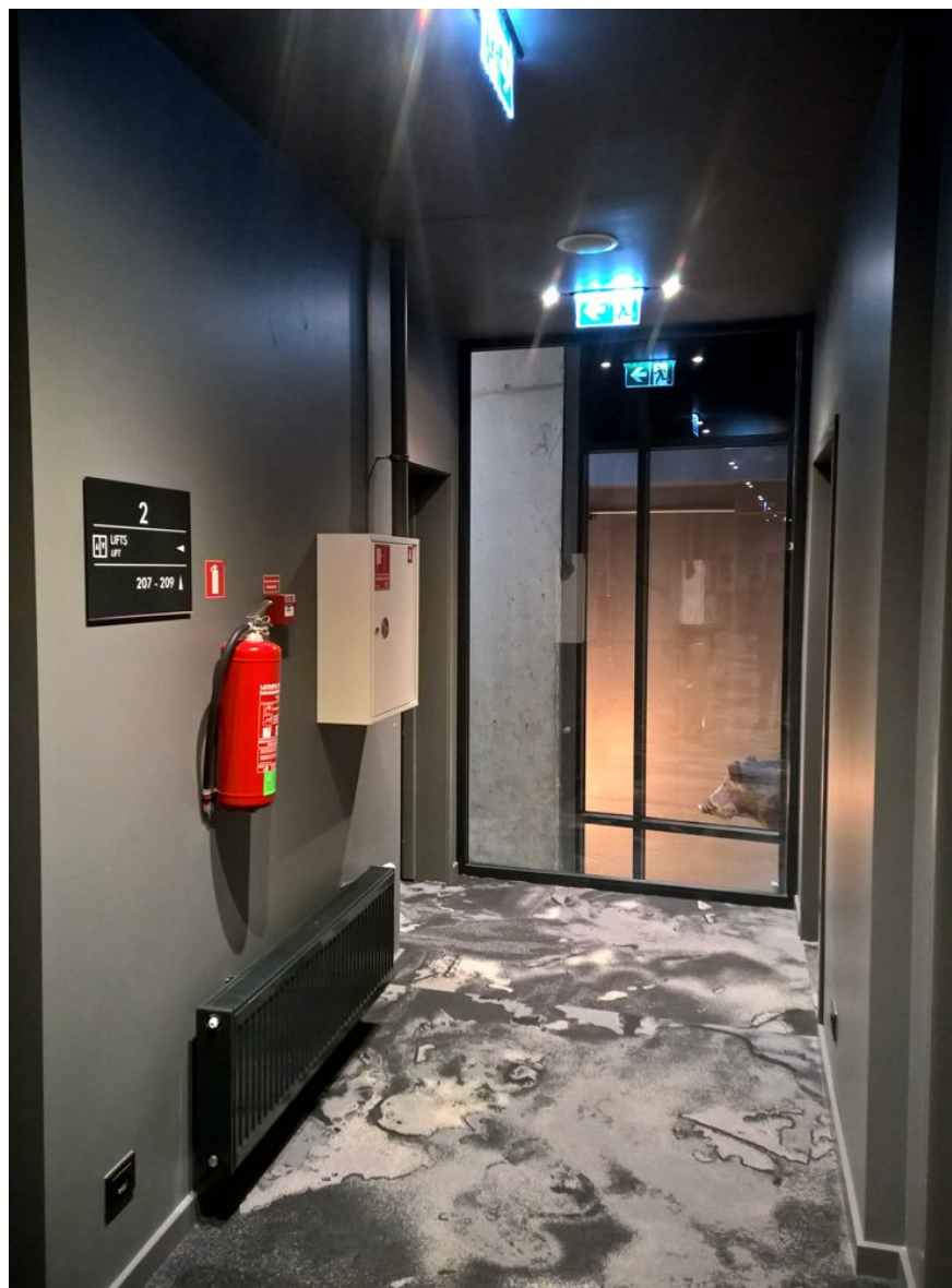
Viesnīca Jēkaba ielā 24: Neapzīmēta stiklotā plakne koridorī pie pagrieziņa.
