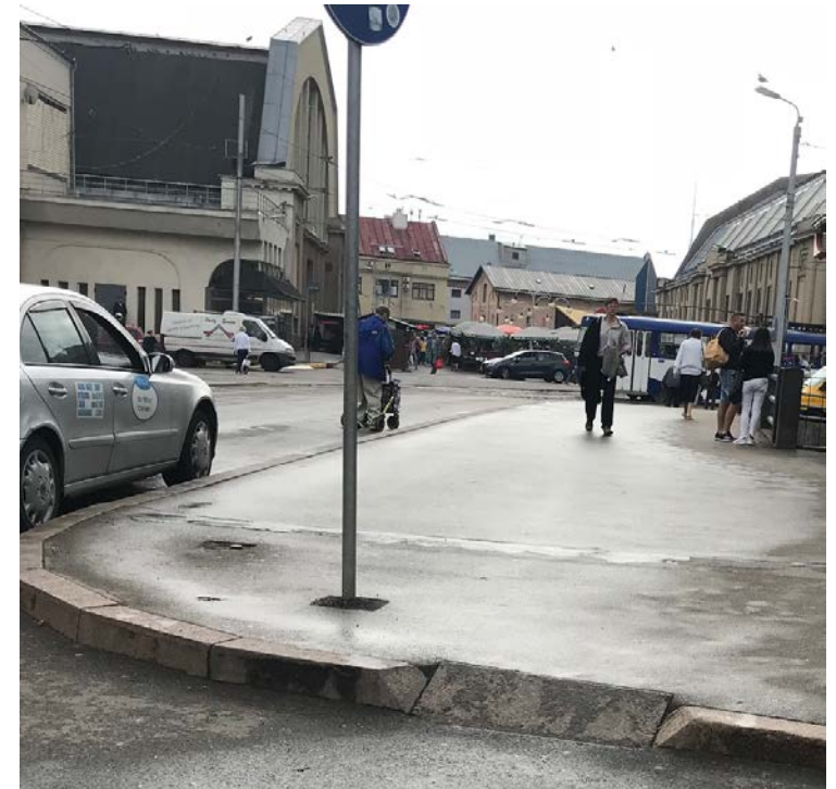
Ietves uzbrauktuve Autoostas pasažieru galerijas pārbūve Prāgas ielā 1
