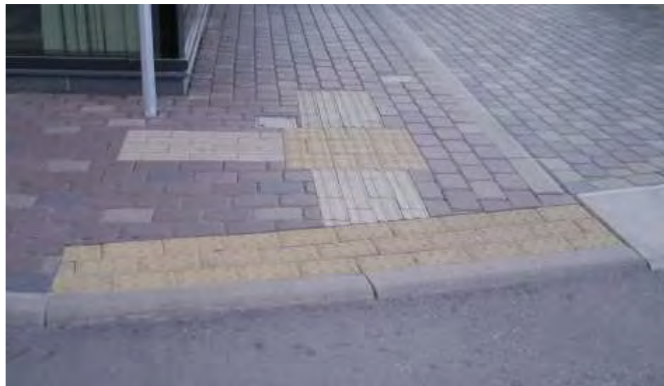
Taktīlo vadlīniju izmantojums bruģī – ietves segumā
