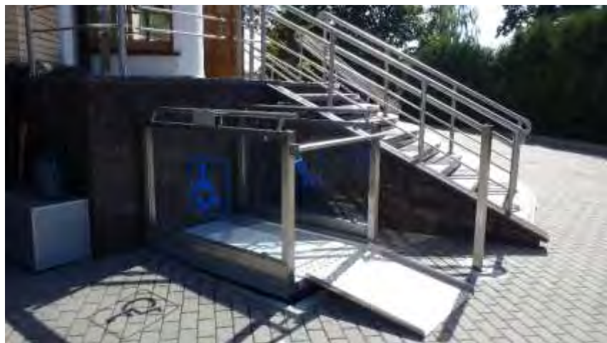
Ēkā vides pieejamība nodrošināta ar pacelāja palīdzību (jautājums vai šis ir pareizais risinājums jaunbūvē)
