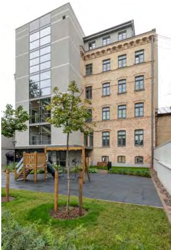
Lifta un kāpņu telpas piebūve – vides pieejamības risinājums ēkas pārbūvei Tallinas ielā 65
