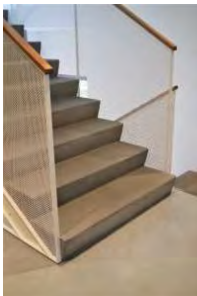
Trūkst pirmā un pēdējā pakāpiena marķējuma, Braila raksta uz margām Dzīvojamā ēka Valkas ielā 4
