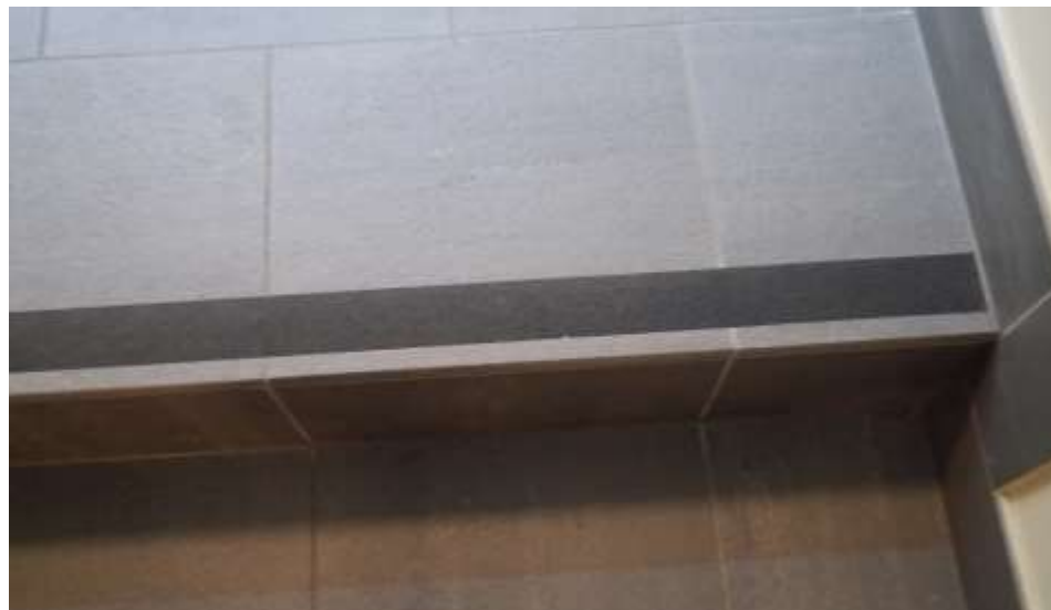
Pakāpienu marķējums ar faktūrā un krāsā kontrastējošu joslu – viens no retajiem objektiem, kur tas ir ievērots
