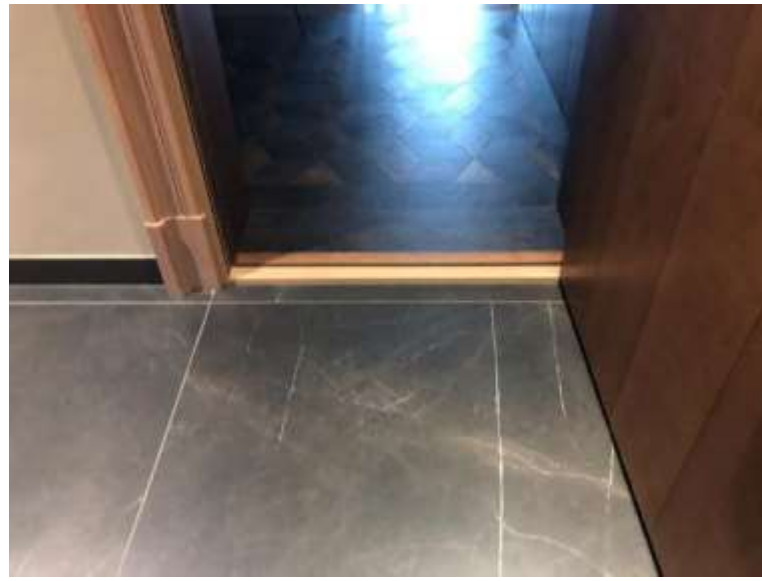
Nemārkēta stiklotā lifta šahta, durvis ar sliksni, lete vienā augstumā, līdzīgs tonālais risinājums durvīm un sienai – nav kontrasta
