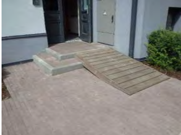
Dzīvojamās mājas Jāņa Asara ielā 12. Formāls pandusa risinājums bez margām ar «sliksni», ieejas visās dzīvojamajās mājās ar pakāpienu vai pakāpieniem
