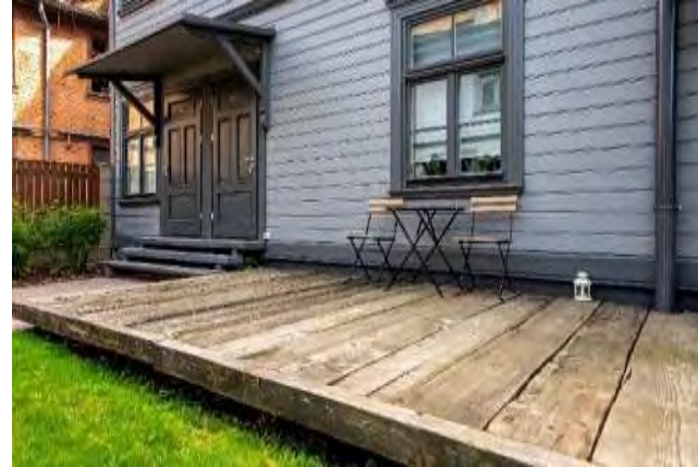
Dzīvojamās mājas Jāņa Asara ielā 12. Formāls pandusa risinājums bez margām ar «sliksni», ieejas visās dzīvojamajās mājās ar pakāpienu vai pakāpieniem
