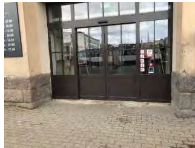
Ieejas durvis bez sliekšņa, automātiskās
