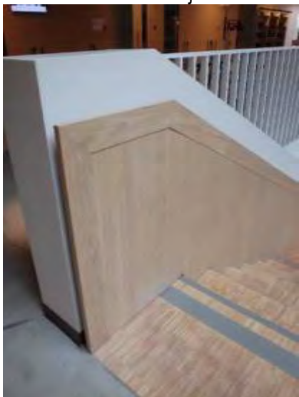
Pirmā un pēdējā pakāpiena marķējums, taktīls uzraksts Braila rakstā uz margām
