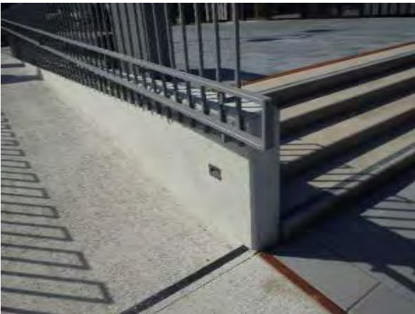
Dažādu materiālu izmantojums, kā arī līmeņu maiņas marķējums, pandusam divlīmeņu margas
