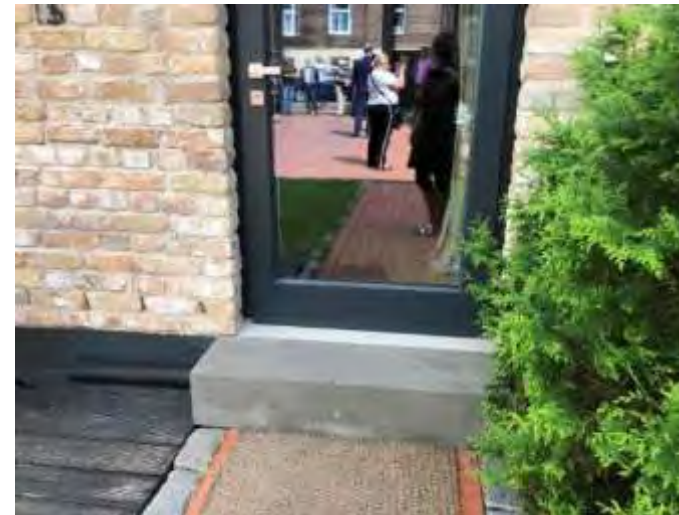
Pakāpieni pirms pilnīgi visām ieejas durvīm dzīvokļos Darbnīcas ēkas pārbūve par daudzdzīvokļu dzīvojamo ēku Mūrnieku ielā 12A
