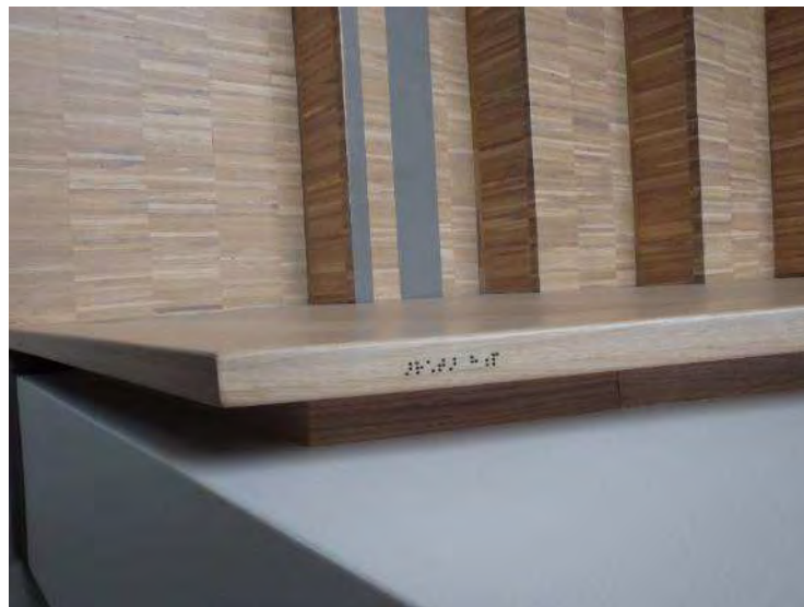
Pirmā un pēdējā pakāpiena marķējums, taktīls uzraksts Braila rakstā uz margām
