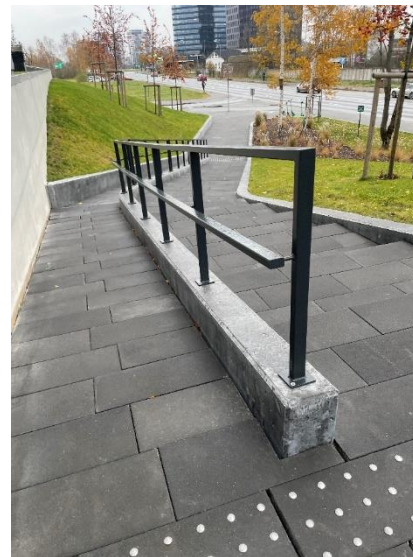
Biroju ēkas būvniecība Rīgā, Roberta Hirša ielā 1 Taktīls brīdinājums pirms līmeņu maiņas; margas divos līmeņos (lai gan tikai vienā pusē); lifta zona izcelta ar citas krāsas grīdas segumu
