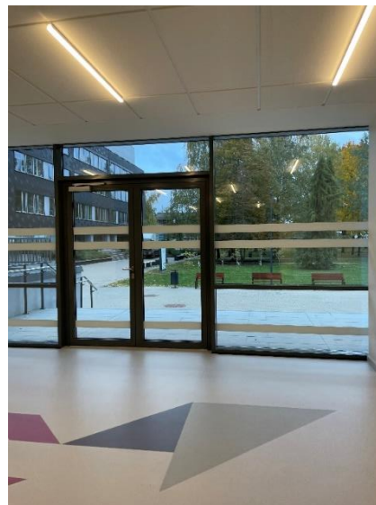
Dienesta viesnīcu jaunbūve Rīgā, Jelgavas ielā 8 un 12 leejas durvis marķētas atbilstoši BVPBN 0,35, 1,4 un 1,6 metru augstumā
