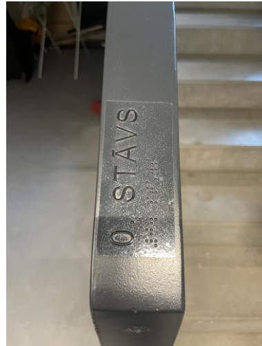
Dienesta viesnīcu jaunbūve Rīgā, Jelgavas ielā 8 un 12 Korekts kāpņu un margu marķējums
