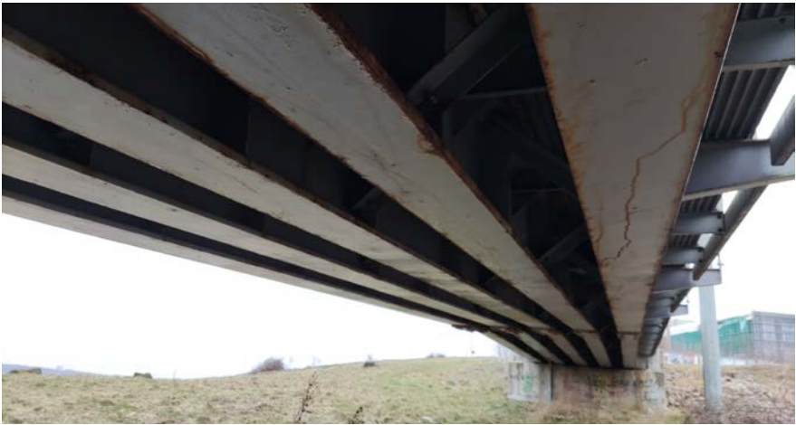
04. Tilta nesošās konstrukcijas vietām sarūsējušas. Nepieciešami atjaunošanas darbi. (Fotofiksācija 2023.02.09)
