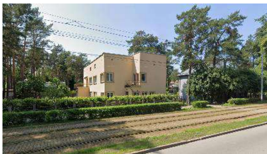
Dzīvojamās ēkas pārbūve un siltināšana, Kokneses prospektā 27
