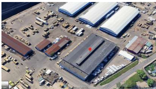
Trīs noliktavu pārbūve (statusa maiņa uz pastāvīgām būvēm). Korpusi A, B, C. Zivju iela 1
