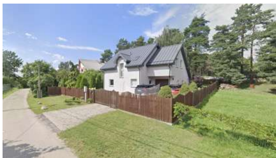
Savrupmājas jaunbūve Steķu ielā 9
