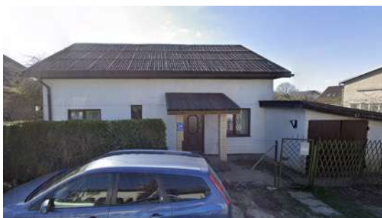
Dzīvojamās mājas un saimniecības ēkas rekonstrukcija Dārziņu 33. līnija 24
