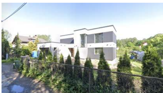
Savrupmājas jaunbūve Mežmalas ielā 8A
