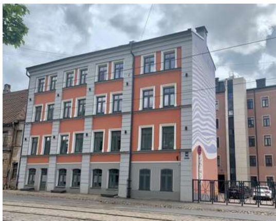
Dzīvojamās ēkas 6.stāva ar mansardu izbūve Maskavas iela 48A
