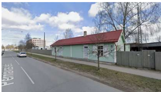
Viesnīcu ēkas pārbūve ar lietošanas veida maiņu Pērnavas ielā 87
