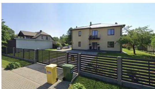
Savrupmājas jaunbūve un esošo ēku demontāža Mazā Bolderājas ielā 10
