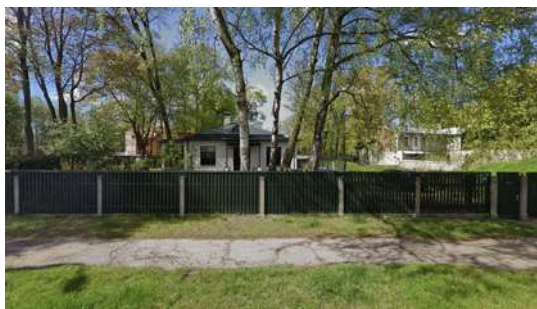
Dzīvojamās mājas pārbūve, pirts un nojumes jaunbūves Āgenskalna iela 31
