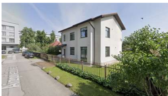
Dzīvojamās mājas rekonstrukcija Aizpriežu ielā 3
