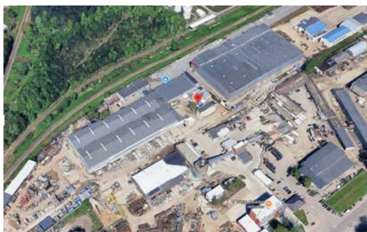
Noliktavas ēkas jaunbūve Spilves iela 18 (ZAĻAIS KORIDORS)
