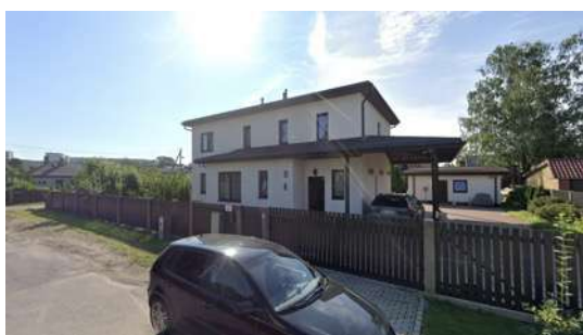
Savrupmājas jaunbūve, garāžas (lit. 002) pārbūve par saimniecības ēku. Dzīvojamās mājas (lit. 001), saimniecības ēkas (lit. 003), siltumnīcu (lit. 004 un lit. 007) un šķūņu (lit. 005 un lit. 006) demontāža Preiļu ielā 20
