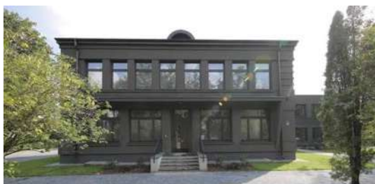
Ēkas pārbūve Stokholmas ielā 26B
