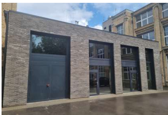
Transformatora apakšstacijas pārbūve par biroja ēku Brīvības gatve 214T, Brīvības gatve 214S, Bērzaunes iela 7A
