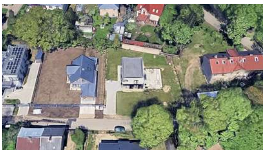
Dvīņu mājas jaunbūve Zemītes ielā 1
