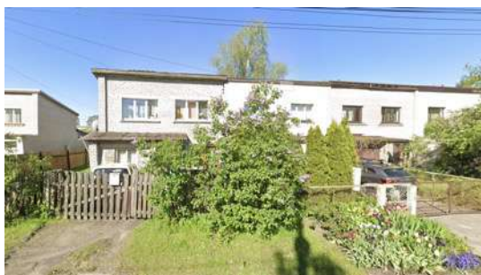
Dzīvojamās majas gāzes apgāde Dauguļu ielā 72 – 2
