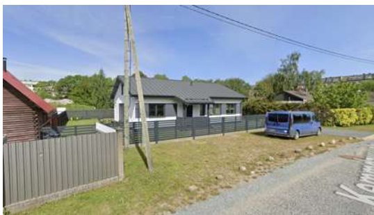
Dzīvojamās mājas jaunbūve Ķemmdziju ielā 29
