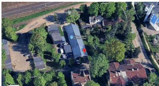
Siltumnīcas ēkas pārbūve par auto diagnostikas pakalpojuma ēku Alsupes iela 15
