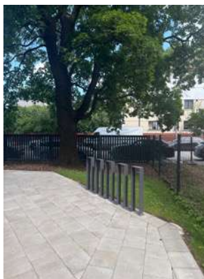
Pārbūve, Sabīles iela 13
