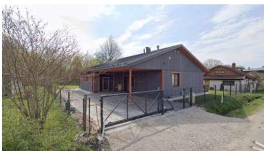
Privātmājas jaunbūve Kvadrāta ielā 44 (RBV)
