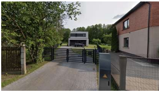
Dzīvojamās mājas jaunbūve Īvandes ielā 15
