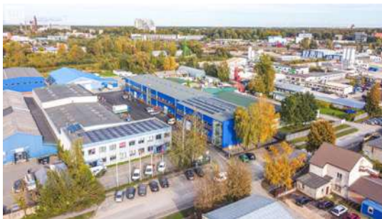
Esošās administratīvās ēkas pārbūve Rāmuļu ielā 17
