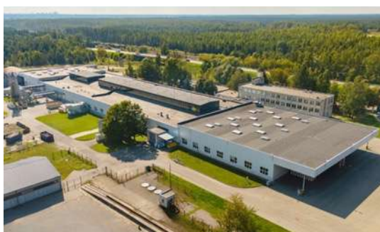
Rūpnīcas HPAKS ražošanas korpusa pārbūve – Fasāde un jumts Finiera iela 2
