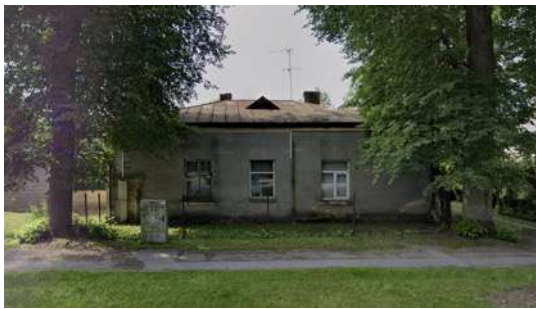
Dzīvojamās mājas rekonstrukcija Jūrmalas gatvē 144A
