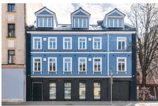
Dzīvojamās ēkas daļēja nojaukšana un pārbūve Krišjāņa Barona ielā 112
