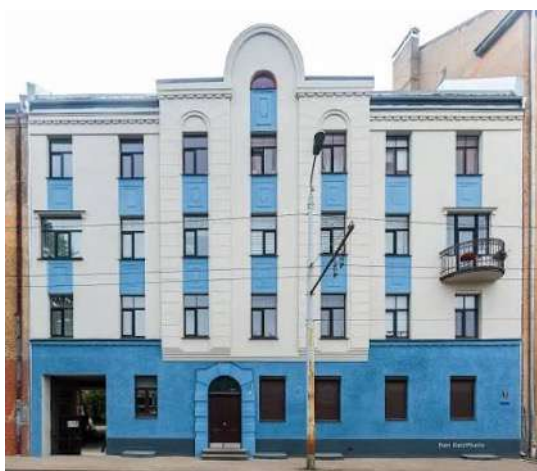
Daudzdzīvokļu dzīvojamās ēkas (lit. 001) balkona un fasāžu atjaunošana, pagrabstāva pārseguma pastiprināšana Kurbada ielā 3
