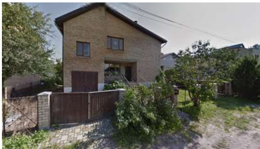
Savrupmājas rekonstrukcija Padures iela 8A
