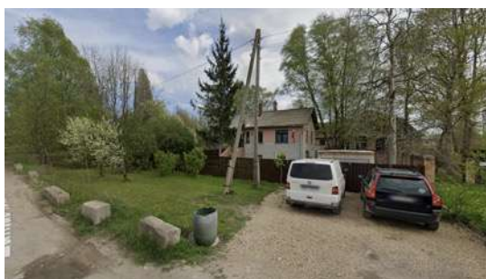
Dzīvojamās ēkas pārbūve Laktas ielā 22
