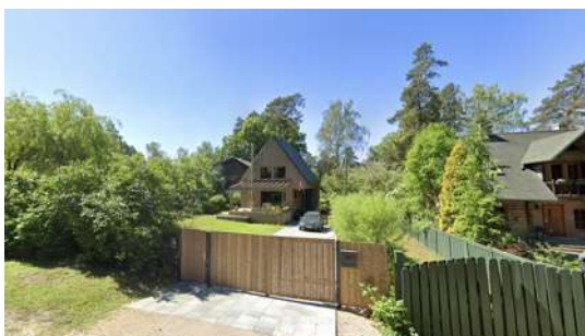
Viendzīvokļa dzīvojamās mājas fasāžu siltināšana, jumta seguma nomaiņa, terases – pergolas izbūve Kārļa Egles iela 28
