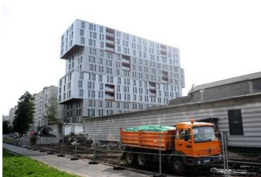
Daudzstāvu dzīvojamās ēkas un tirdzniecības centra ekspluatācijā nodotās 1.kārtas apjoma daļēja nojaukšana un pārbūve Priedaines iela 20
