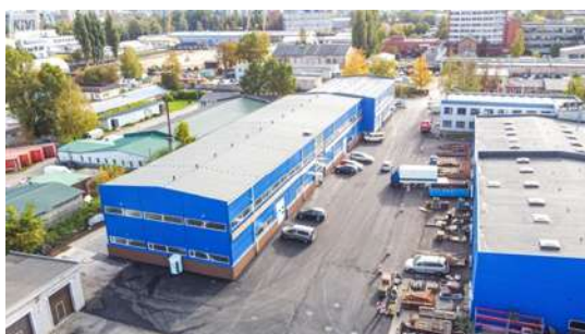
Noliktavu komplekss: ēku 1, 2, 3 jaunbūve, esošo ēku (lit. 002, 006) demontāža Rāmuļu ielā 29
