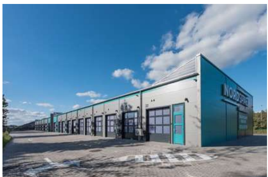
Nordspace noliktavu jaunbūve Lubānas ielā 133A
