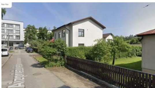
Savrupmājas rekonstrukcija un paplašināšana Aizpriežu ielā 6
