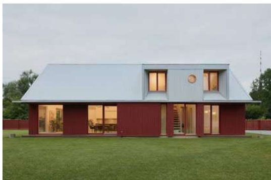
Savrupmājas un palīgēkas jaunbūve Komētas ielā
