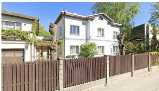
Piebūve dzīvojamai mājai Kuršu ielā 17
