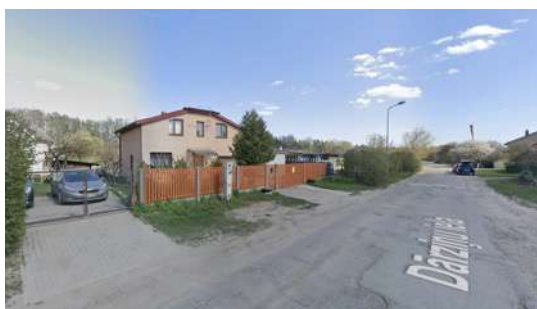
Vienas ģimenes dzīvojamās mājas pārbūve Dārziņu iela 65
