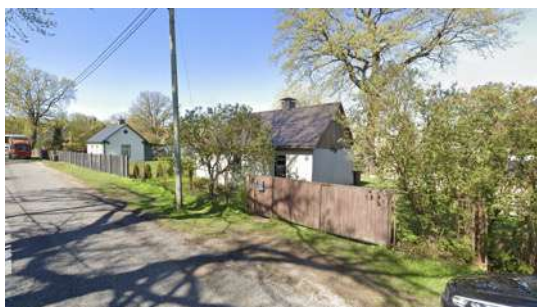
Dzīvojamās mājas pārbūve Zaru iela 20
