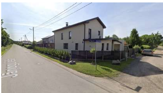
Dzīvojamās mājas pārbūve Jāņogu ielā 118
