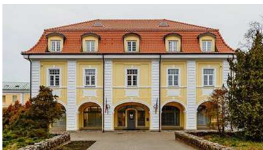
Ēkas pārbūve un teritorijas labiekārtošana Citadeles ielā 7
