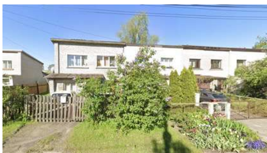
Dzīvojamās ēkas rekonstrukcija Dauguļu iela 72
