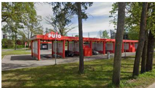
Autostiklu apkopes darbnīcas nojaukšana, automazgātavas jaunbūve Jaunmoku ielā 30
