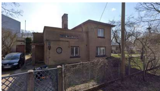
Dzīvojamās ēkas pārbūve Bukas ielā 3
