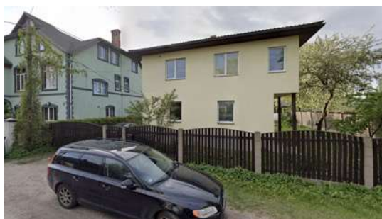
Savrupmājas lit.012 rekonstrukcija Raicenes iela 21, Rīga
