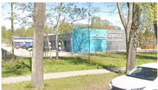
Noliktavas ēkas jaunbūve, atkritumu konteineru novietnes un velo novietnes jaunbūve, ēku lit. 5, 12, 15, 16, 22, 24, 25, 28, 34, 37, 44 nojaukšana. I etaps (ZAĻAIS KORIDORS) Jūrkalnes iela 62
