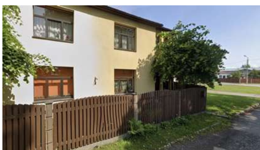
Dzīvojamās un saimniecības ēku un garāžas rekonstrukcija Remīnes ielā 14
