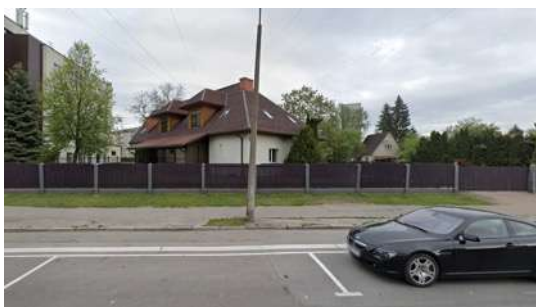
Dzīvojamās mājas rekonstrukcija Gaiļezera ielā 3
