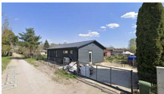
Dzīvojamās mājas jaunbūve un esošas ēkas demontāža Dārziņu 3. līnija 7
