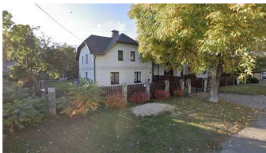
Dzīvojamās ēkas rekonstrukcija un saimniecības ēkas pārbūve Teteru ielā 19
