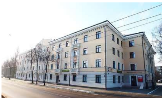
Viesnīcas ēkas rekonstrukcija. 2. kārtā Lauvas iela 1
