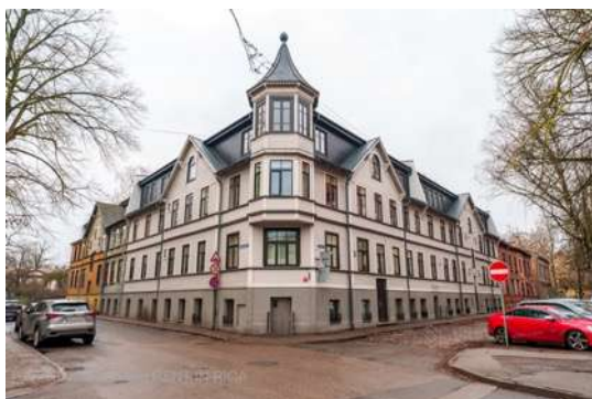
Dzīvojamās ēkas rekonstrukcija Zellu ielā 13
