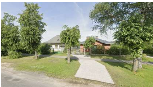
Dzīvojamās mājas rekonstrukcija un pirts jaunbūve Taisnā ielā 59
