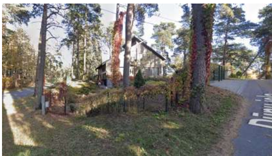
Savrupmājas jaunbūve Dzintara ielā 26 (RBV)
