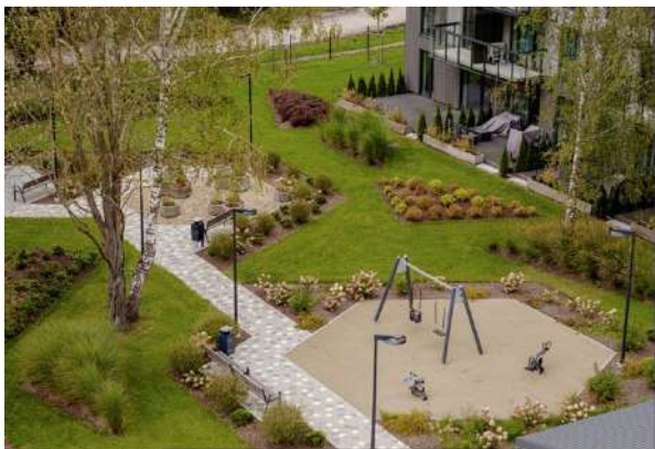
Moho Garden – daudzdzīvokļu dzīvojamo māju jaunbūve Ķīšezera iela 10
