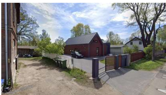
Dzīvojamās ēkas jaunbūve Apguldes ielā 10A
