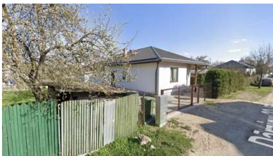
Dārza mājas rekonstrukcija par dzīvojamo māju, dārziņi Dārziņu 33. līnija 15
