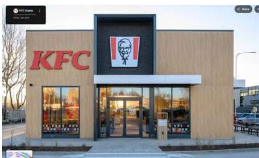
Restorāna ēkas, biroja ēkas un 2 noliktavu ēku jaunbūves Krasta ielā 83
