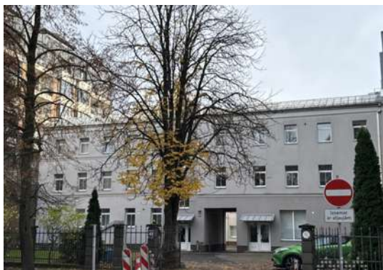
Ēkas rekonstrukcija Rūpniecības ielā 42
