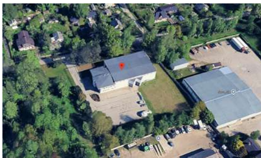
Noliktavas telpu grupu pārbūve. Būvprojekta izmaiņas Ūdeļu iela 16
