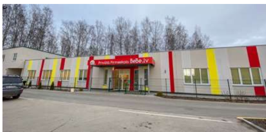
Bērnu dārza jaunbūve autostāvvietas nojumes vietā Līvciema ielā 48
