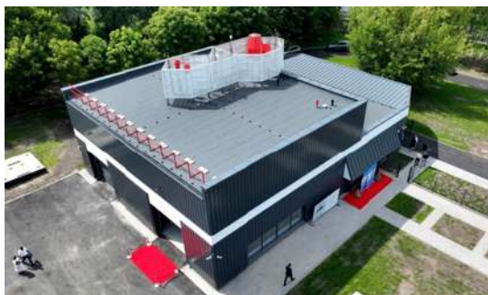
Sūkņu stacijas ēkas pārbūve Antenas ielā 3A, lit. 005
