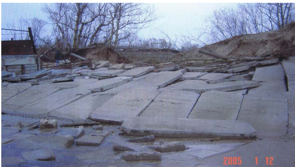
Att. 3.13. 2005.gada vētrā sagrautais Daugavgrīvas krasta nostiprinājuma rietumu gals (G.Eberharda foto, 2005)
