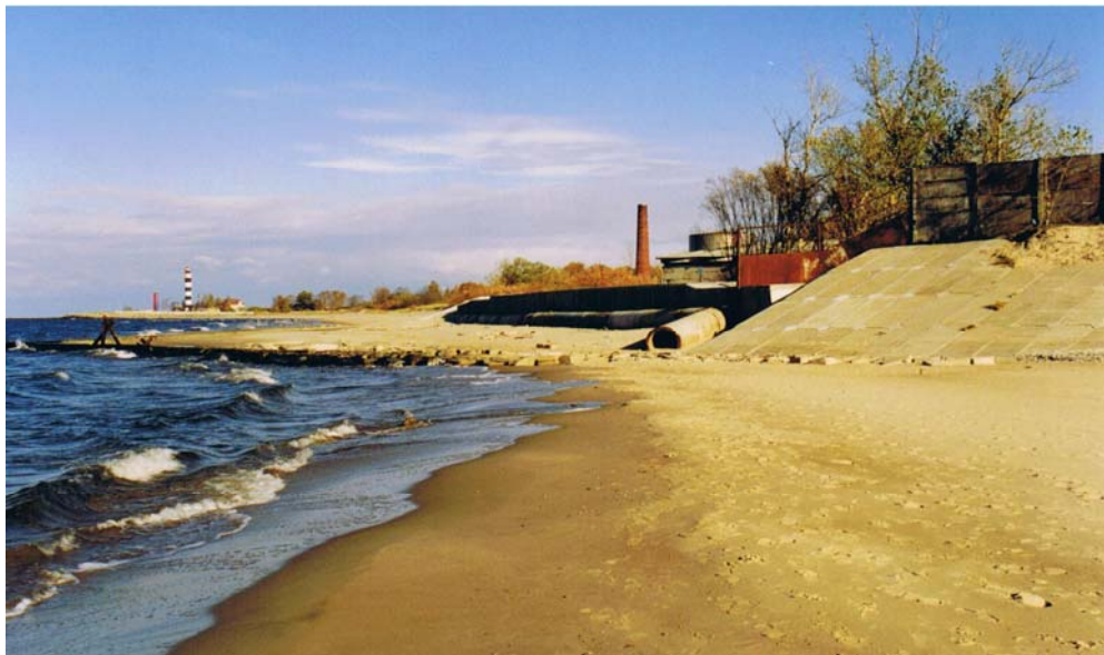
Att. 3.8. Atkārtoti atjaunotais (2002.gadā) 2001.gada vētrās sagrautā krasta stiprinājuma gals (G.Eberharda foto, 2002)
