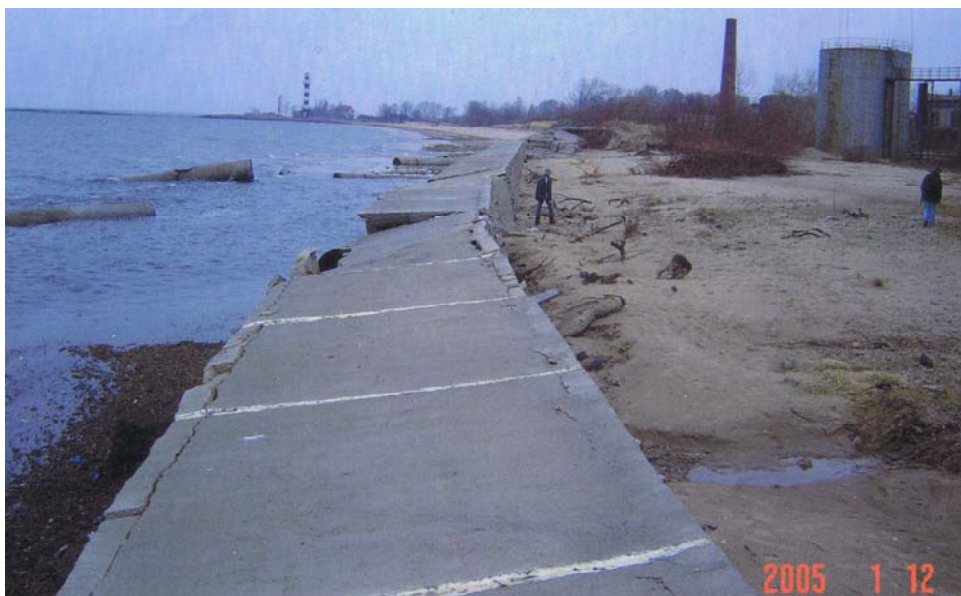
Att. 3.12. Sagrautais Daugavgrīvas betonētais krasta nostiprinājums (G.Eberharda foto, 2005)
