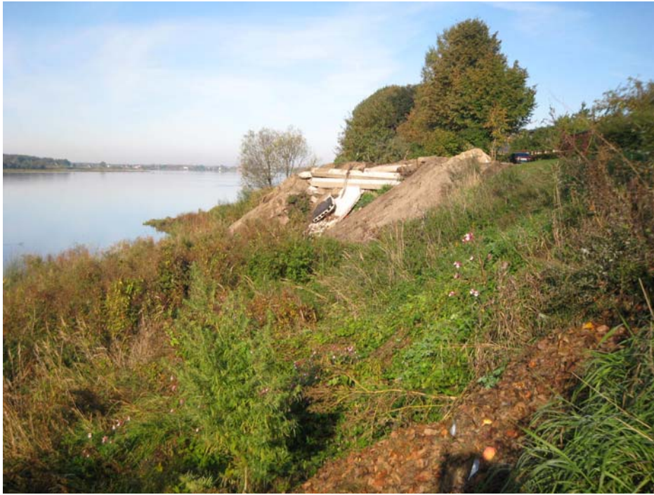
Att. 3.16. No lielgabariņa būvgružiem veidots krasta stiprinājums Dārziņos, Daugavmalas iela (M.Gravas foto, 2010)
