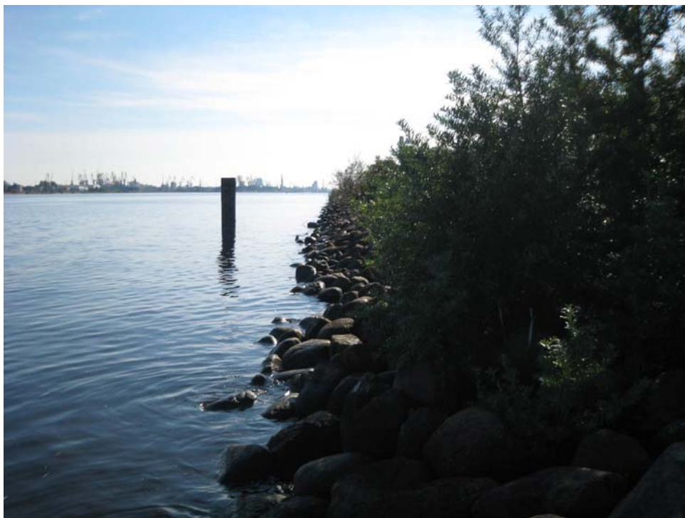
Att. 3.20. Laukakmeņu krasta stiprinājums Voleros (M. Gravas foto, 2010)
