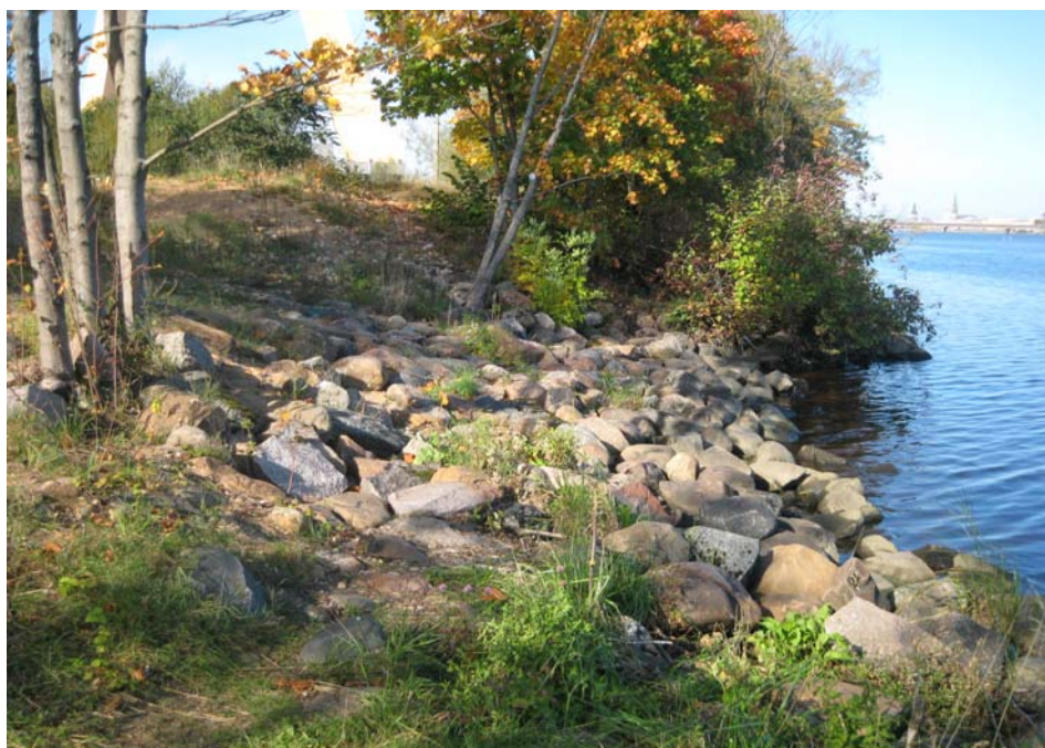
Att. 3.19. Lokāls krasta izskalojums virs ar laukakmeņiem nostiprinātas Zaķu salas krasta joslas (M. Gravass foto, 2010)
