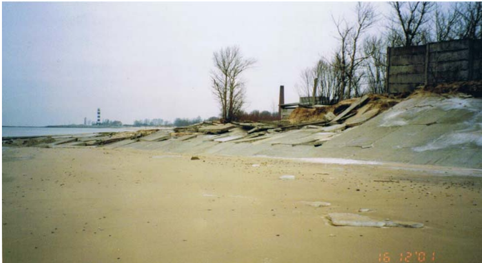
Att. 3.7. 2001.gada 1. un 15.novembra vētrās sagrautais krasta stiprinājums pret bijušo kuģu remonta rūpnīcas rietumu galu (G.Eberharda foto, 2001)
