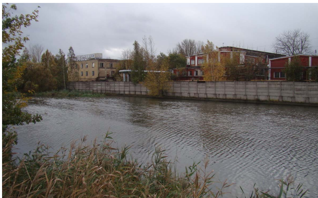
Att. 2.12. Kanāls (grāvis) īsi pirms Ganību dambja tilta. Teritorija norobežota ar vienlaidus betona žogu. Foto no punkta 1 (att. 2.11), J.Virbulis, 2010.
