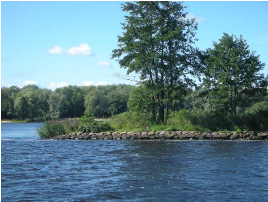
Att. 3.23. Mīlestības salīņas ar laukakmeņu krāvumu nostiprinātais DA gals (S.Dišleres foto, 2009)
