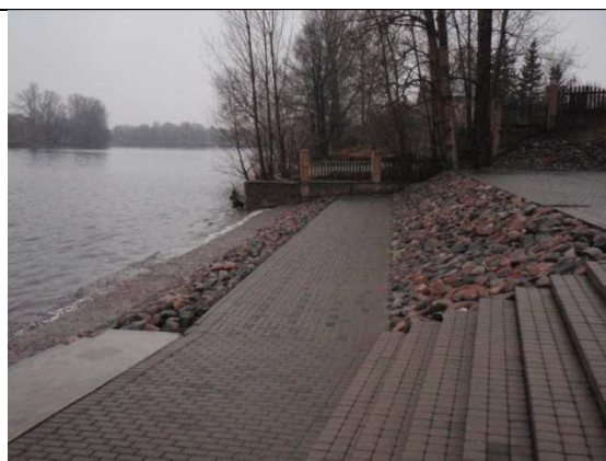
Att. nr. 47. Āgenskalna līča krastmala pie Swedbank ēkas.
